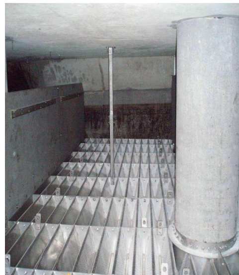
Tamiz estático de 82m 2 instalado en un tanque de tormentas en la Isla de Man.
