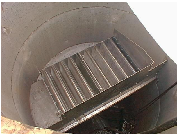
Tamiz estático de dimensiones 680X500X300 mm, para estación de bombeo.
